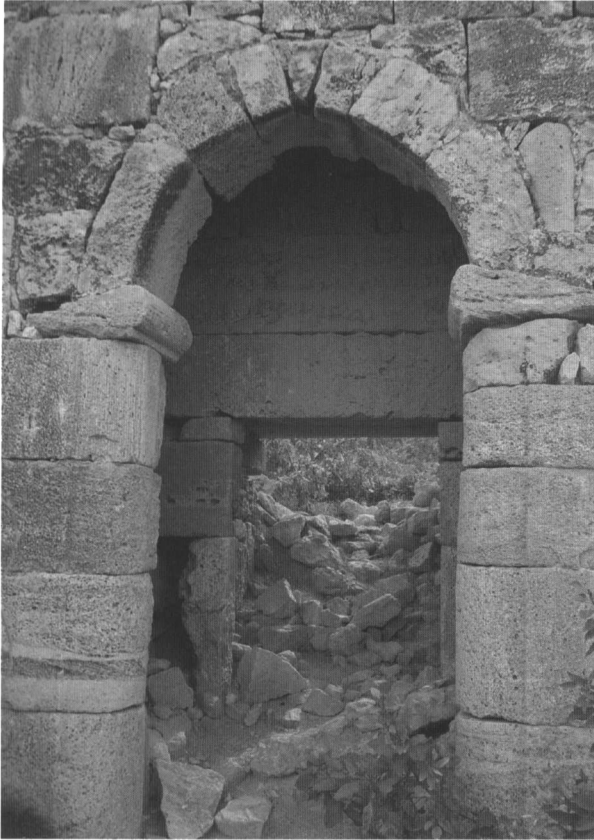
Figure 4. La position de l'inscription arabe, surmontant l'entrée abritée par un porche.
