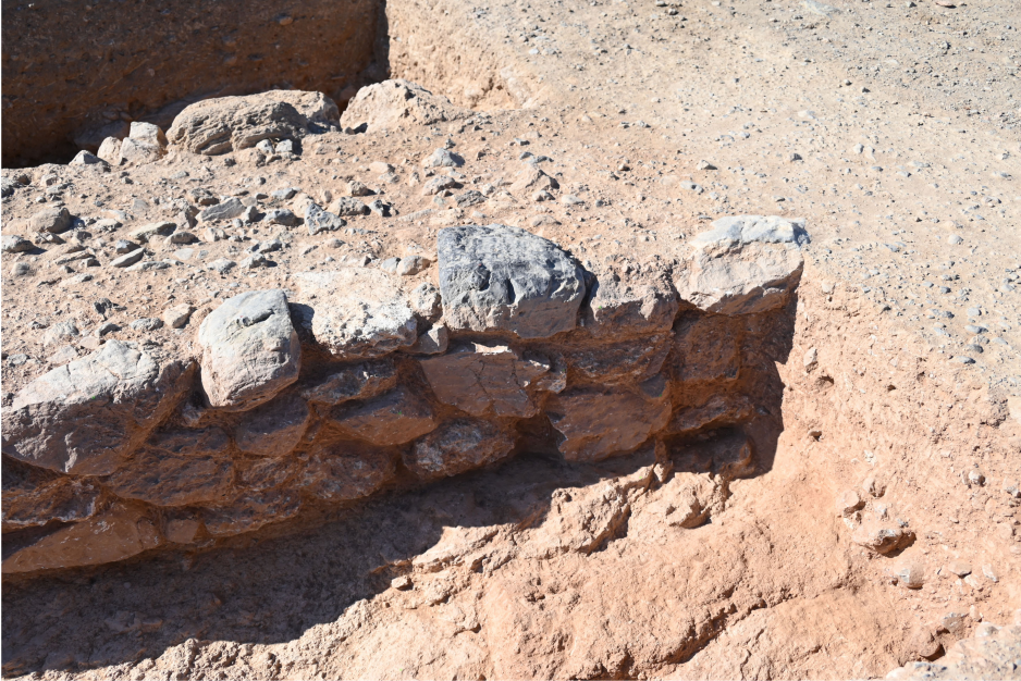
Fig. 3.75. Itanos: the exterior of a section of the city wall. © Mission archéologique d'Itanos 2023.
