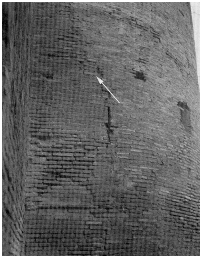
FIG. 10. Torre I. Esterno: resti della finestra della prima fase. (Foto: Robert Coates-Stephens.)
