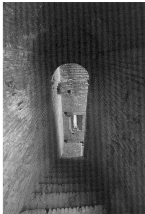
FIG. 21. Torre 3. Dall'interno. (Foto: Fabio Barry.)
