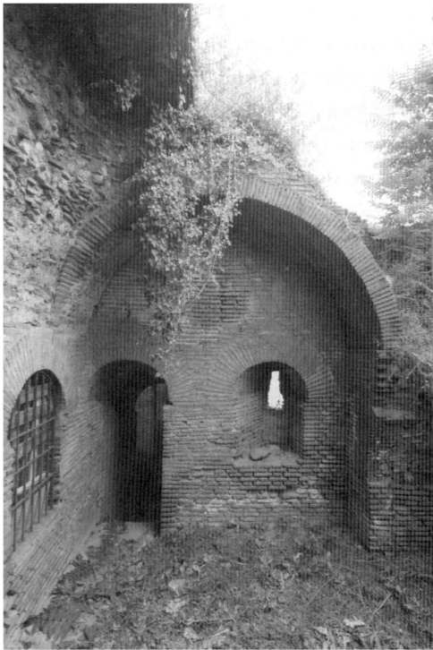
FIG. 50. Torre 10. Interno, lato verso Porta Latina. (Foto: Fabio Barry.)
