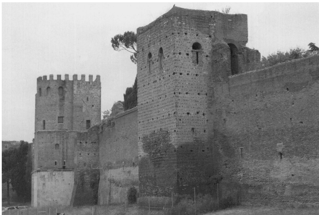
FIG. 52. Torre 11. Esterno. Si noti il protiro e l'opera listata. (Foto: Fabio Barry.)
