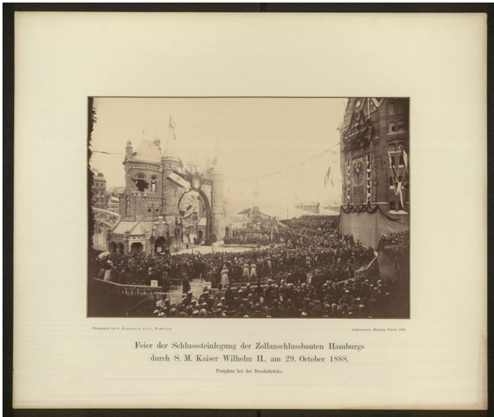
Figure 7. Georg Koppmann, Schlusssteinlegung der Zollanschlußbauten Hamburg's am 29ten October 1888 , Hamburg 1888, 12.
