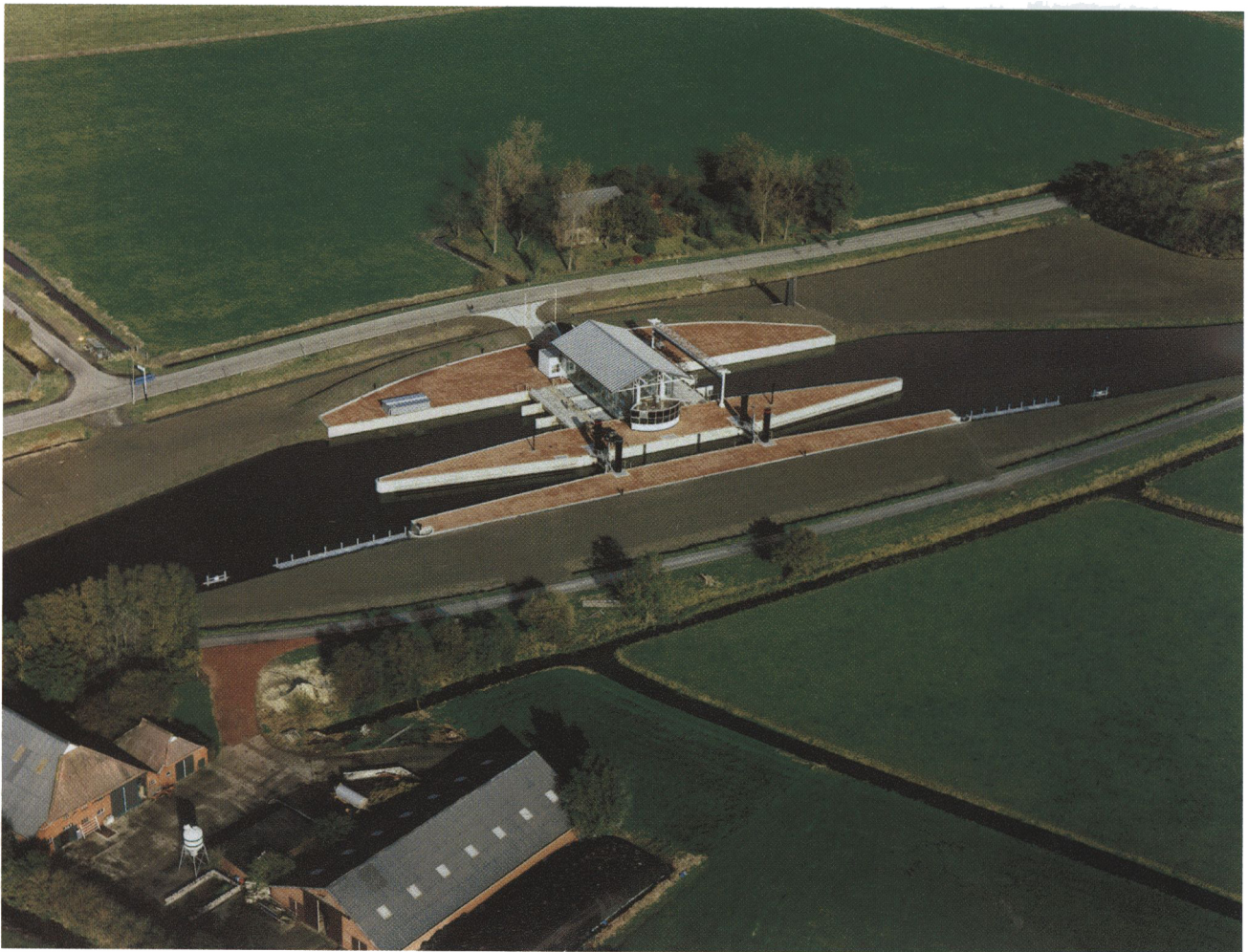
Fig. 11. Pumping station Den Deel (NE of city of Groningen) (Luchtfoto Aerophoto Eelde).
